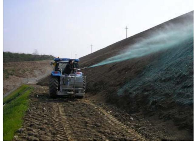
Foto inerbimento scarpate con pendenza 35° lato sud della Cava ex Viabit
