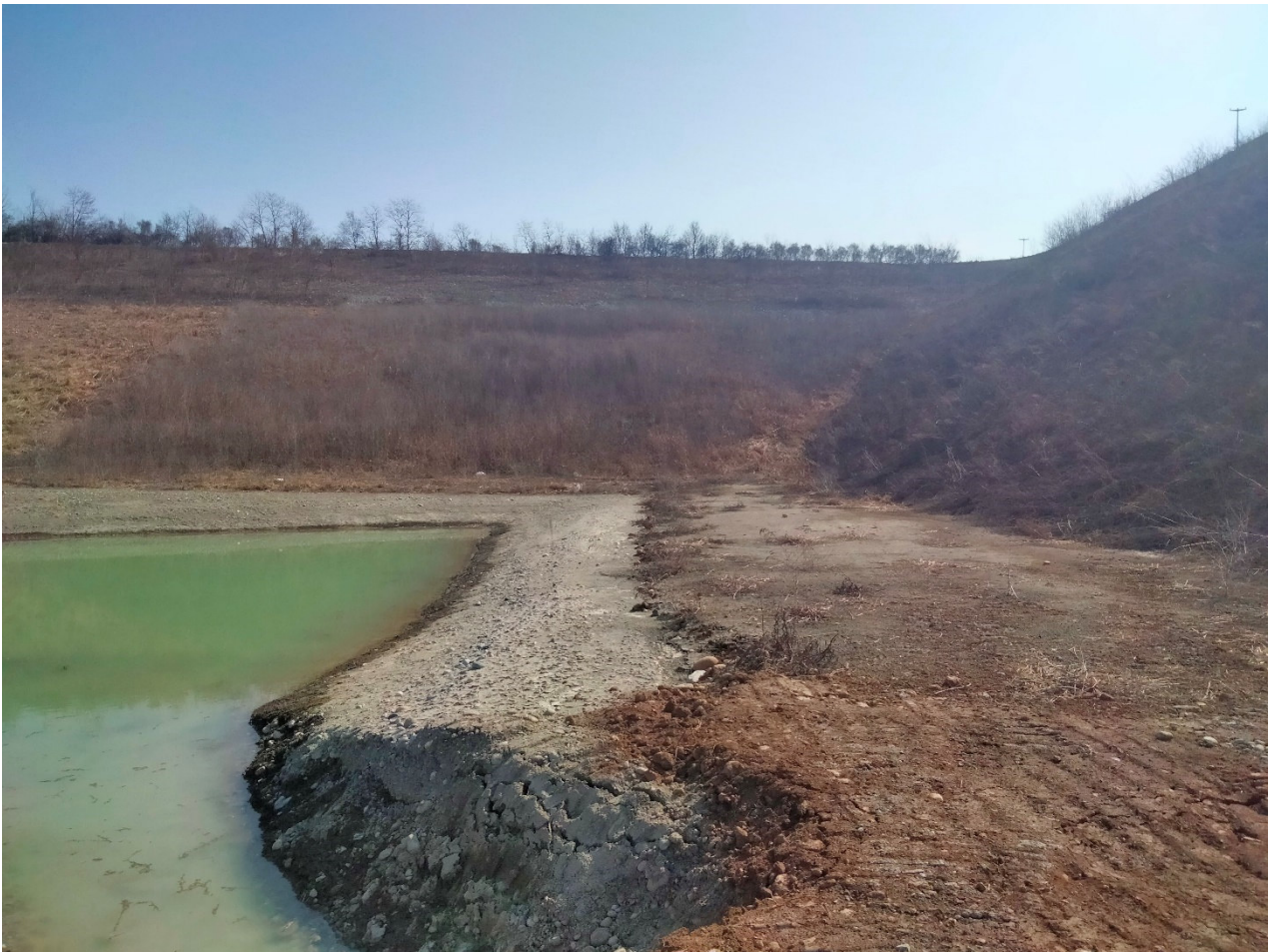
Foto 4: dettaglio sponda del laghetto per osservare gli strati di materiale inerte posizionato
