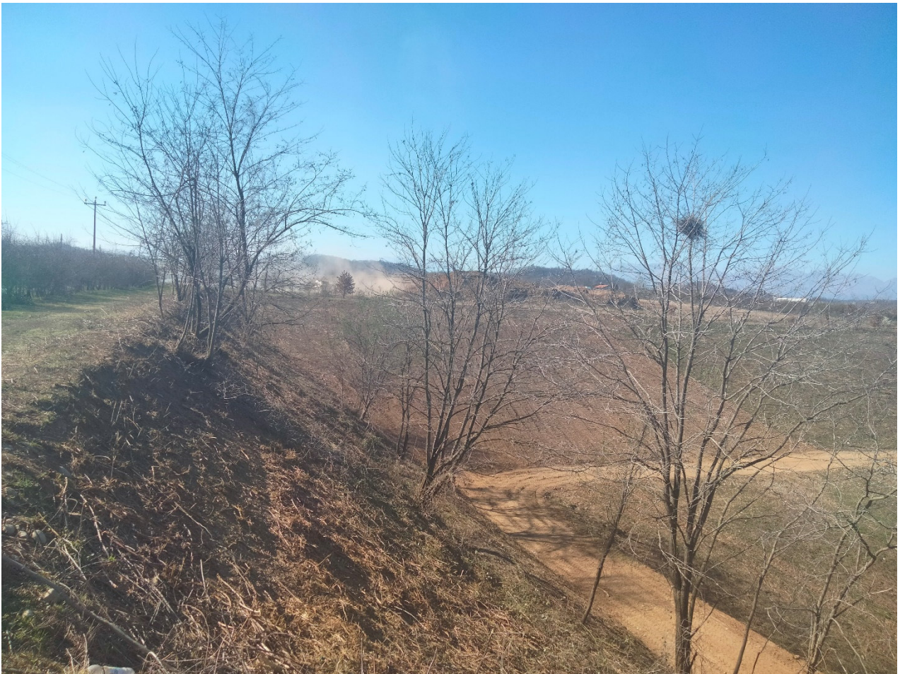
Foto 8: ulteriore dettaglio della parte ovest dell'area di cava. Si osserva sulla sinistra la siepe perimetrale che costituisce barriera fonoassorbente parallela alla strada di accesso. La scarpata di cava è stata riprofilata, è stato riportato il terreno agrario e sono state completate le operazioni di semina
