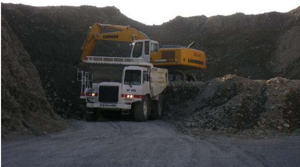
Fase di scavo e carico del tout-venant sul fronte
