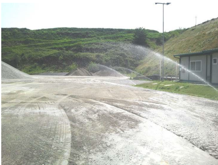
Particolare sistemi di abbattimento piazzale di carico
