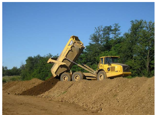
Fase di accumulo del terreno vegetale
