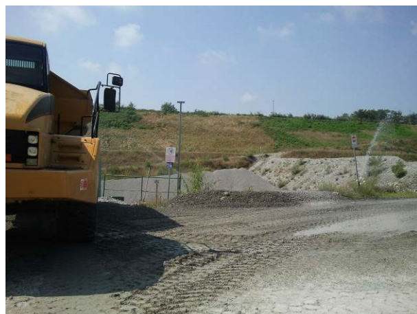
Particolare zona di scarico tramoggia di alimentazione impianto
