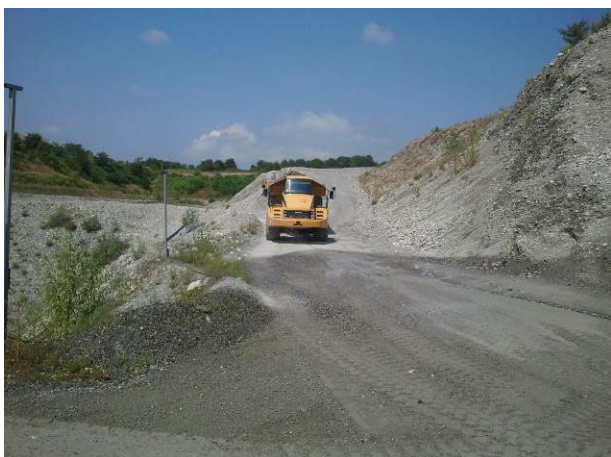
Particolare pista dal fronte di scavo all'alimentazione impianto di lavorazione
