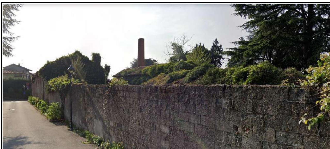
Illustr. 2: Foto degli edifici visti da nord
