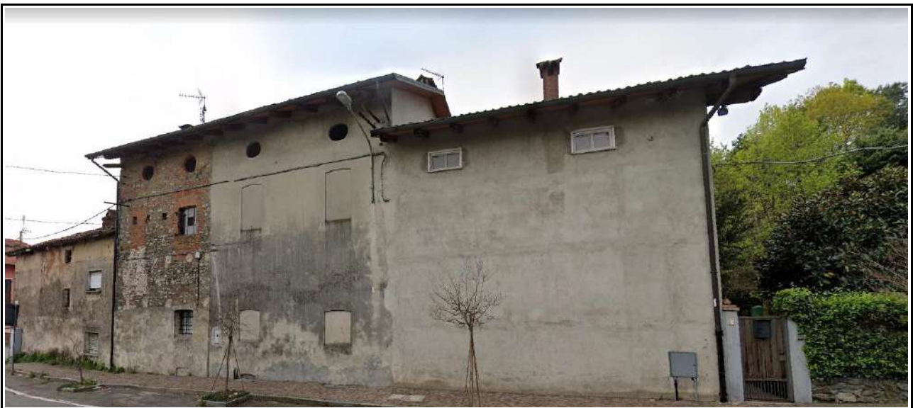
Illustr. 6: Foto degli edifici visti da nord
