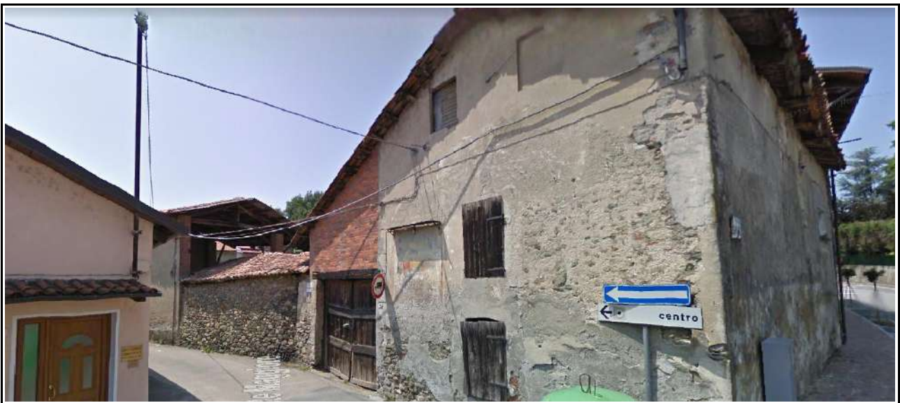
Illustr. 4: Foto degli edifici visti da nord-est
